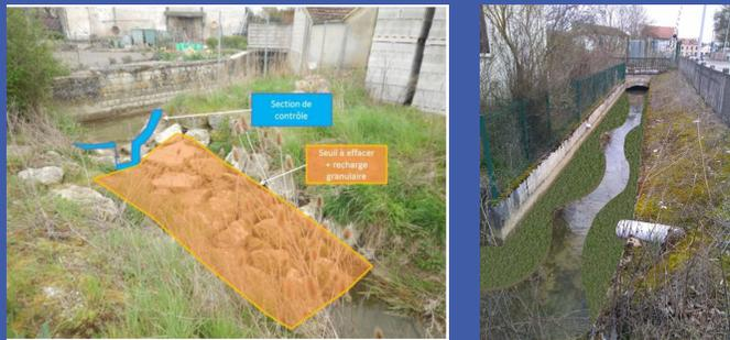
Sur le Bras de Bresse, les travaux viseront à renvoyer les flux dans le fossé SNCF avec la création d'un ouvrage de régulation en béton à l'entrée du bras, en lieu et place des batardeaux actuels. Ces travaux seront complétés par le reprofilage du cours d'eau afin de bénéficier d'un lit d'étiage pour les débits les plus faibles. Il pourra également se retrouver asséché les années les plus sèches.
