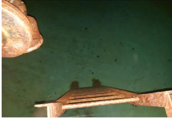
RÉSERVOIR 2 : Accès à la chambre des vannes et à la cuve non sécurisés et hors normes.
